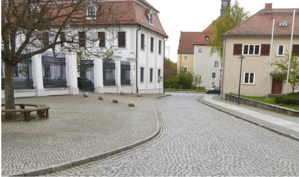
† Pflasterarbeiten in der Gerichtsstraße in Lübben: Hier wurden insgesamt 1.345 Quadratmeter Kleinpflaster, 420 Quadratmeter Mosaikpflaster und 310 Quadratmeter Granitplatten verlegt. Die Abbildungen zeigen den südlichen Bereich (l) ab der Reutergasse mit Blick in Richtung Houwald-Damm sowie den nördlichen Bereich (r) ab Hauptstraße mit Blick in Richtung Reutergasse.
